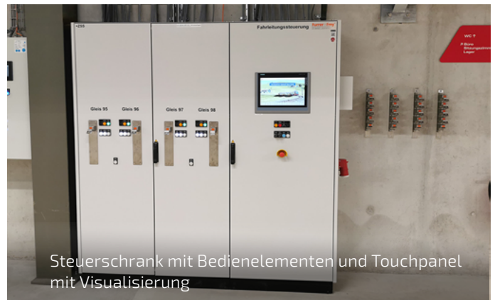
Die Fahrleitungsschalter schalten bzw. erden die vier Fahrleitungen
